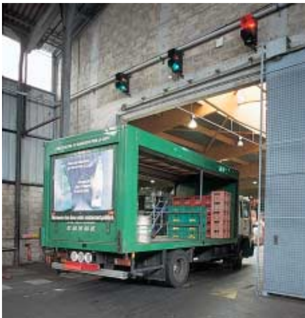
Feu vert/feu rouge à l'intérieur d'un entrepôt
