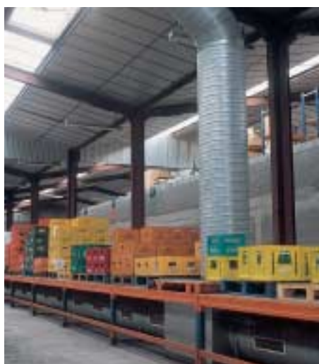
Captage des gaz d'échappement
