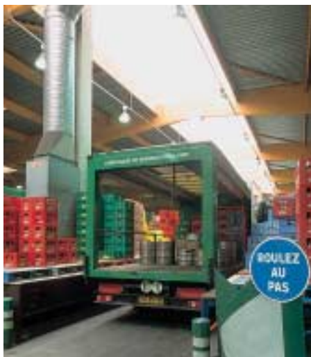
Captage des gaz d'échappement
